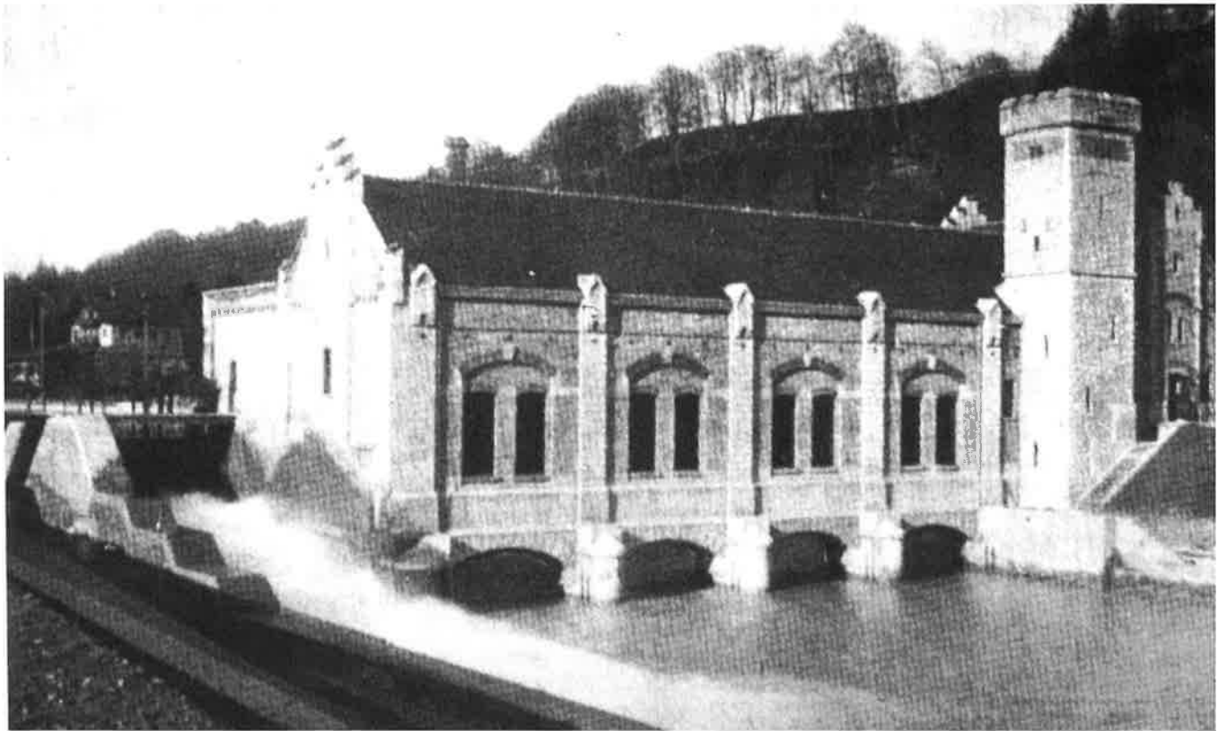
Wasserkraftanlage in Höllriegelskreuth bei München
