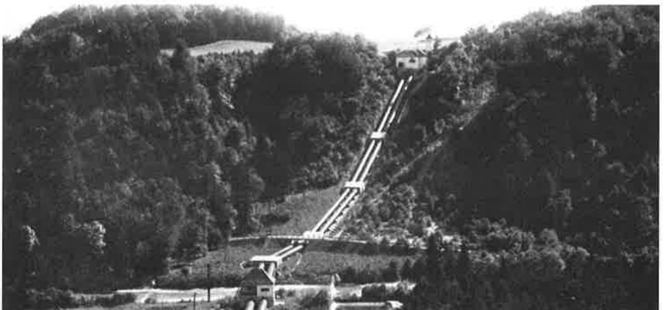
Wasserkraft-Anlage Leitzachwerke, Dückerleitung durch das Leitzachtal. 1911 - 12 Entwurf: Geh. Oberbaurat Dr. e.h. Schmidt, München Ausgeführt: Tiefbau und Eisenbeton - Gesellschaft
